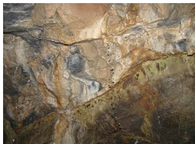
图5 巷道围岩渗漏水
